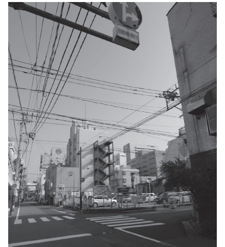
●明石通り・中央郵便局前交差点から駅南に抜ける「新潟駅東線」の整備は放置されたままで、影響が心配される
