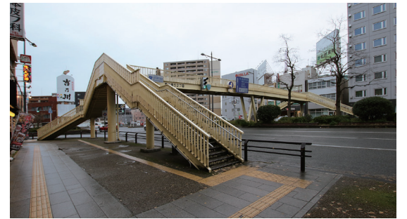
●東大通に架かる、30段超の流作場五差路歩道橋
