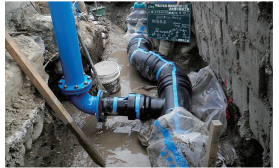
●老朽化した水道管の取替や新たに水道管を埋設する場合、耐震機能を有する耐震管が施工されている
