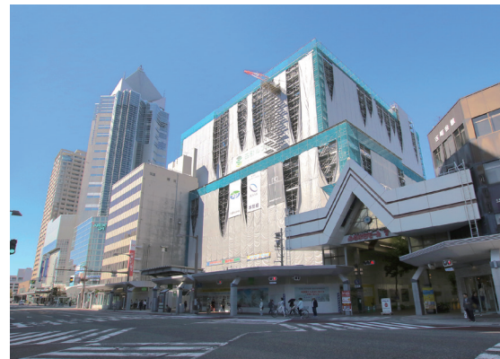
●来春オープンに向けて建設が進む大和デパート跡地
